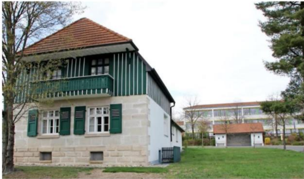
Mit einer Hackschnitzel-Heizzentrale in der Schule (im Hintergrund) könnten auch das Rathaus (vorne) und der Kindergarten mit Wärmeenergie versorgt werden.
